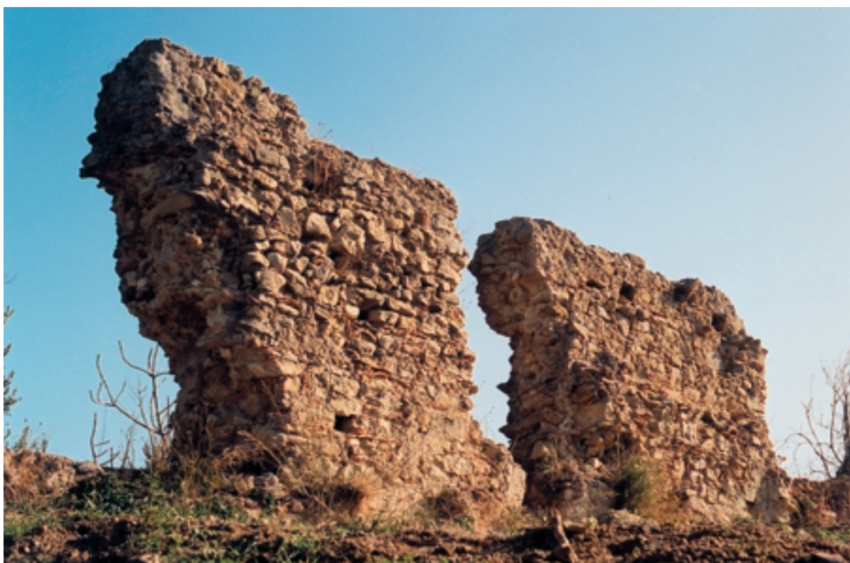
Casabona vecchia - Ruleri del palazzo Pisciotta: parte di un muro dell'androne [Foto G. Tallarico]
